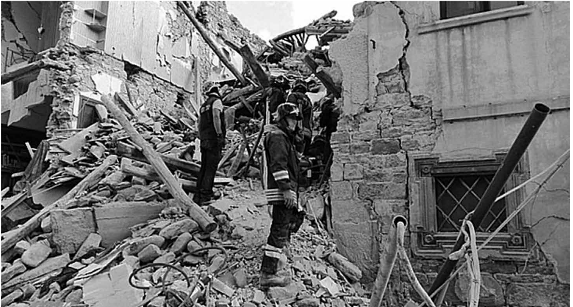
As equipes de resgate continuam as buscas nos escombros em cidades italianas mais atingidas pelo forte terremoto, que atingiu 6,2 graus na escala Richter
